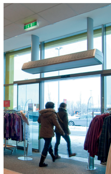
Figure 2 Rideau d'air : assurer le confort en porte ouverte.
